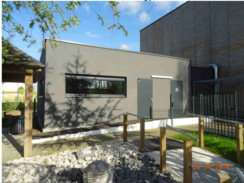
Construction d'une annexe de l'éco-gymnase
